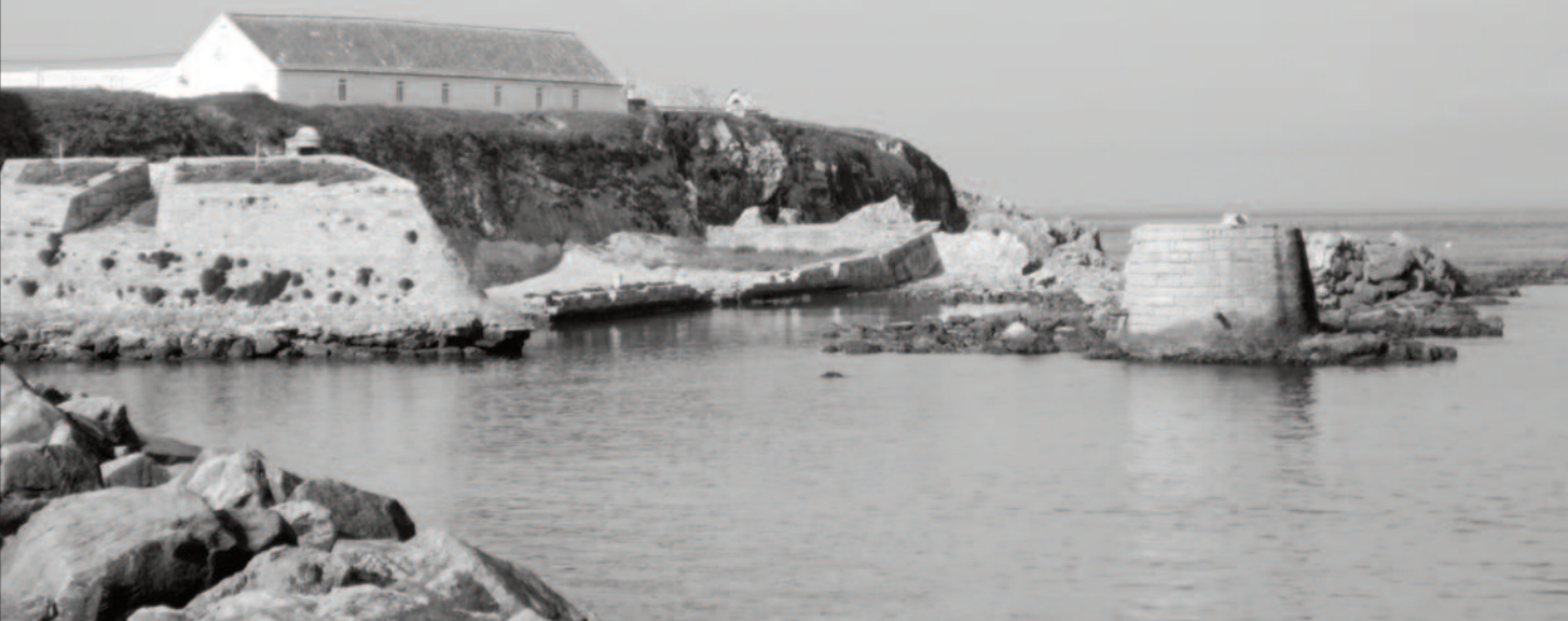
Imagen 1.-Una vista general de la dársena desde el Paseo Marítimo. Foto: I. Sena
