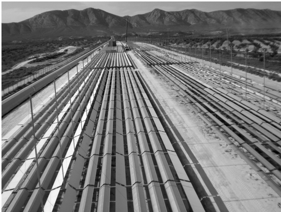
Figura 14. Central Puerto Errado 1.
