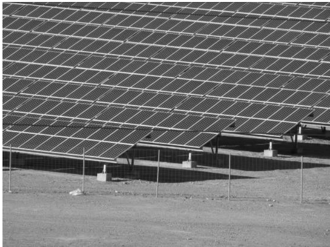
Figura 3. Módulos de silicio monocristalino.
