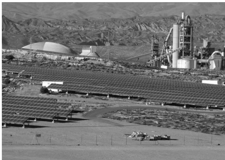
Figura 13. Localización junto a instalaciones industriales.
