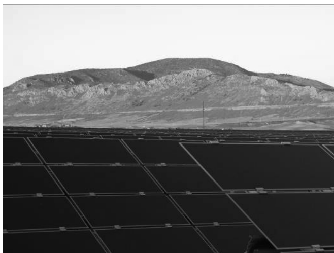
Figura 10. Módulos de silicio amorfo.
