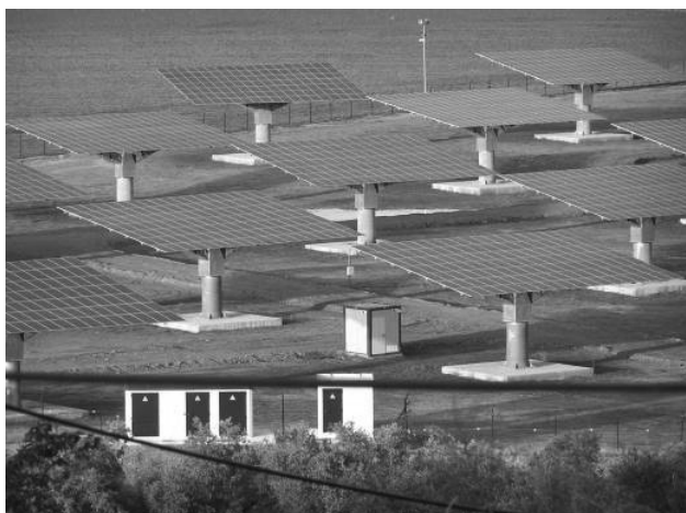
Figura 9. Bases de hormigón.
