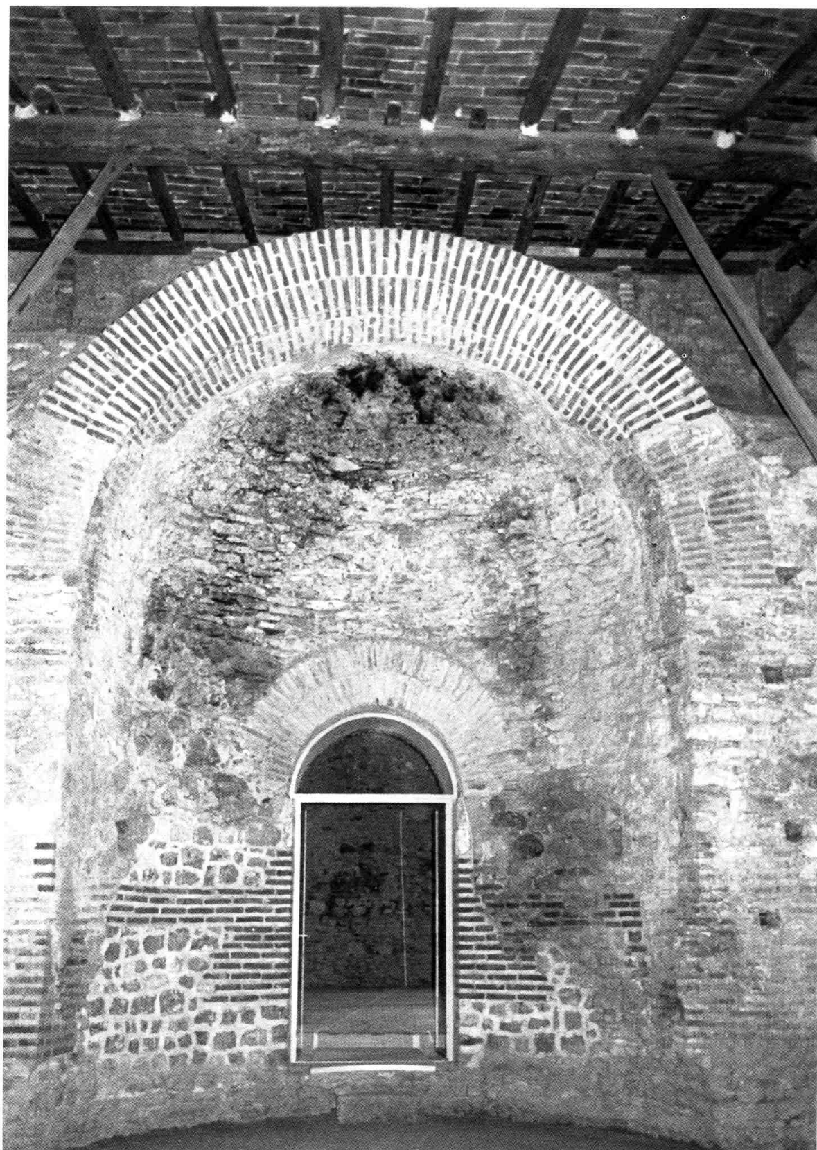
Sala cuadrilobulada antes de su restauración final
