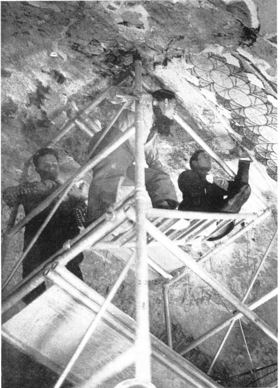
Durante los trabajos de la limpieza de la cúpula
