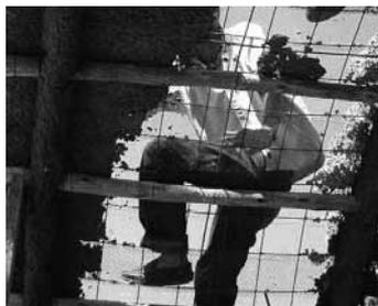
Figura 6. Se cuelan los arcos y luego el plemento del cilindro de malla electrosoldada sobre metal desplegado con concreto 1:2:3 de bajo revenimiento.
