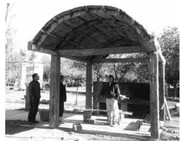
Figura 7. Bajo la bóveda de 7 x 4 m se genera una casa potencial en embrión, tras ocho horas de labor.
