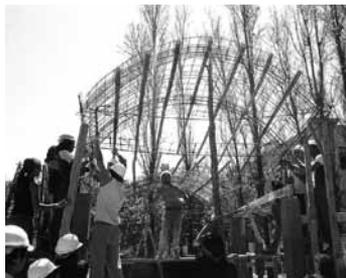
Figura 5. La bóveda prearmada en el piso es izada al enrarse de sus paramentos de soporte.
