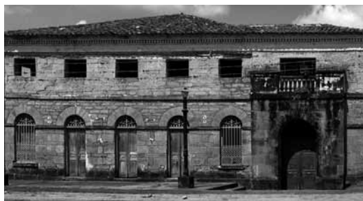
Figuras 2 a 5. Real Fábrica de Hierro São João de Ipanema. Fábrica de Armas blancas. Exterior, interior, altos hornos y almacén. Fotografías: Víctor Hugo Mori.
