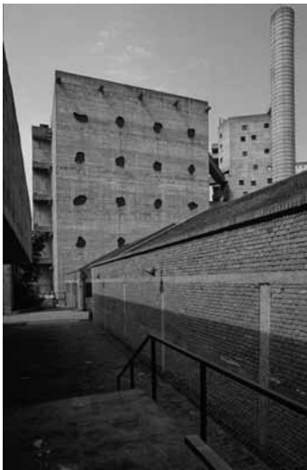
Figura 10. Nuevas edificaciones. Fotografía: Hugo Segawa.
