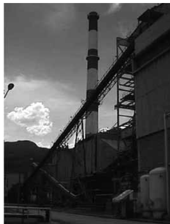
Figura 1. Chimenea de la termoeléctrica de Tasajero.
