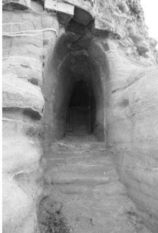
que existen, de trecho en trecho, arcos rebajados de ladrillo que se apoyan sobre jambas de piedra. Otras galerías más estrechas y de factura más tosca, a modo de minas, conducen a otros puntos del conjunto defensivo, como la zona alta y la entrada, o bien al exterior del recinto. En la ladera del cerro se pueden ver algunos restos de galería, que seguramente corresponden a la antigua poterna<sup>13</sup>.
