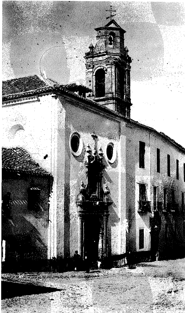
Hospital de San Juan de Dios. Fachada antigua. Entrada principal (1931).
