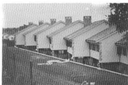
Fig. 6. Las viviendas de "La Campa" adoptan en planta una disposición en escalera, para adaptarse a la pendiente del terreno.
