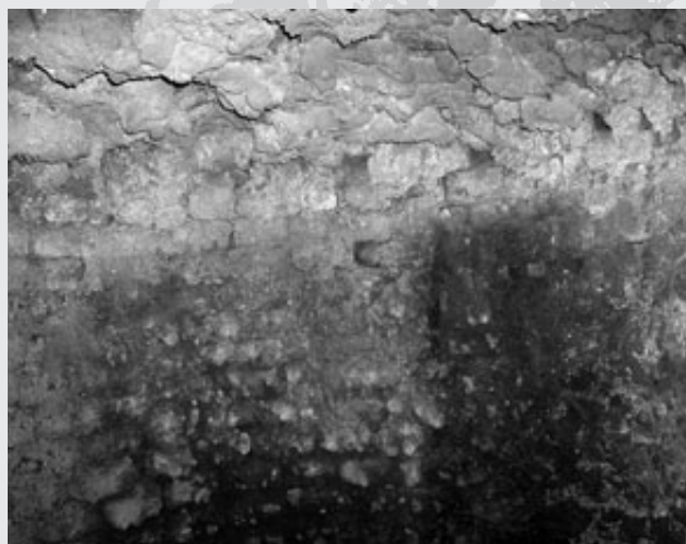
DETALLE DEL INTERIOR DEL HORNO; LA ZONA DE MUSGO COINCIDE CON LA ORIENTACIÓN NORTE, LA PARTE DE LA PARED OPUESTA A LA PUERTA. J. GARCÍA-MARIBONA.
