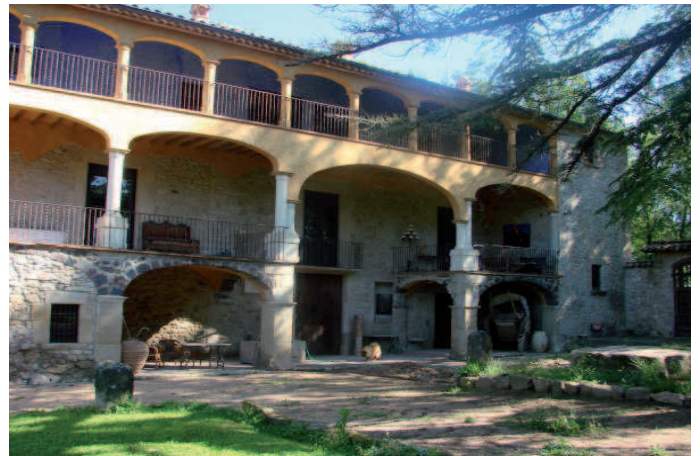
Vista de la façana principal de la Cau (masia on s’allotjava el cap del camp de concentració) Foto: D. Colom
