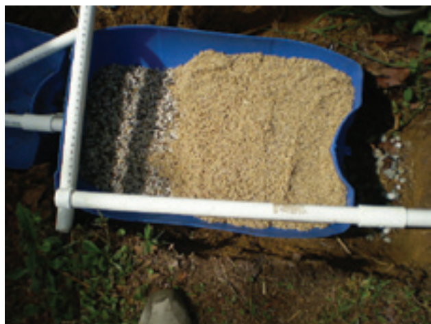
Foto 4. Construcción del humedal
