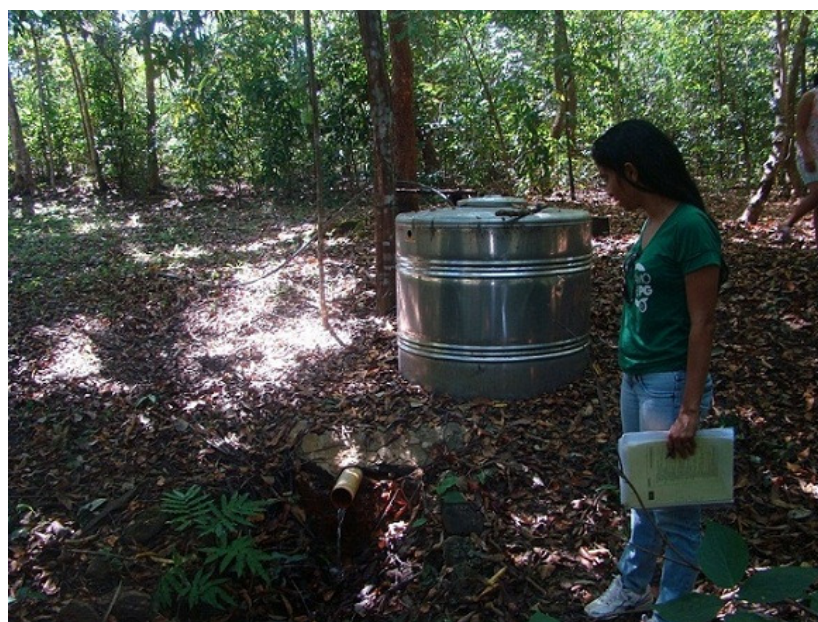
Figura 9 – Caixa d'água instalada sobre nascente.
