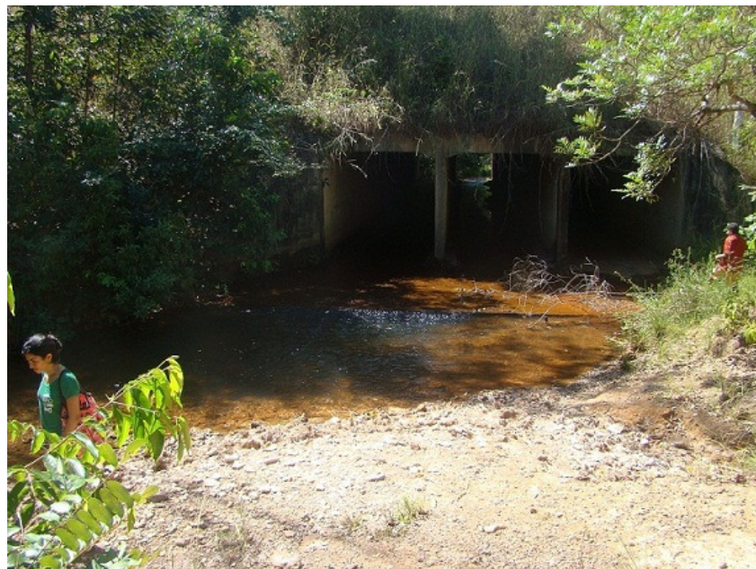
Figura 8 – Obra de engenharia sobre o leito do Ribeirão Jaú.
