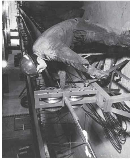
Fabricación de postensados para Edificio BCH, Bogotá. Archivo: Esguerra, Saenz, Samper.
