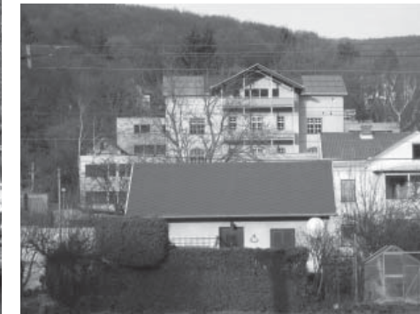
Vista del conjunto desde el costado sur.
