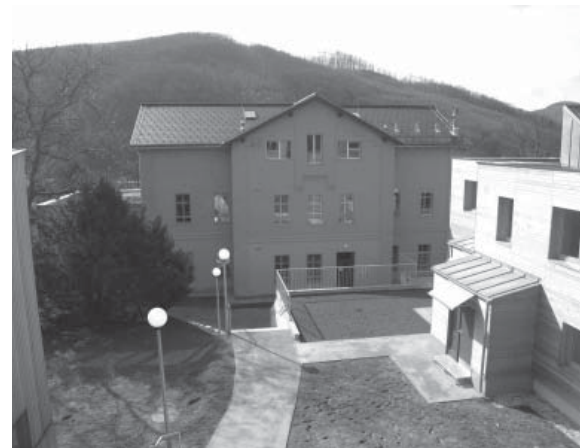
Fotografía de la fachada posterior de la Villa.
