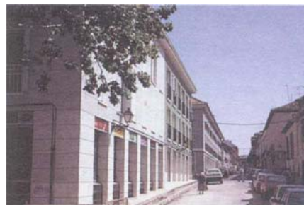
Manzana construida según Ordenanza de Renovación. Urban block constituted under the Renewal Ordinance. Javier M. Atienza y Julio Gómez, arquitectos.
