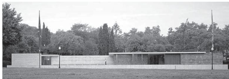
Vista General del Pabellón de Alemania en Barcelona (www.miesbcn.com)
