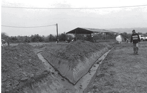
Figura 2. Vista del sistema de canales para drenar el agua proveniente de la depresión de las napas freáticas en la investigación en el Pozo de Vargas (Archivo Fotográfico GIAAT).
