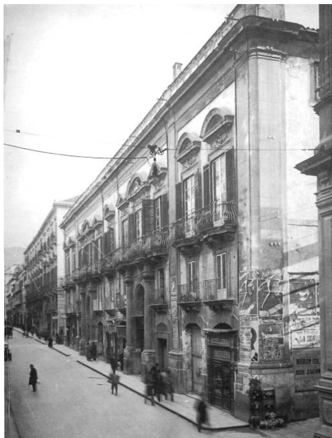
Fig. 3. Palermo, palazzo Comitini, prospetto principale su via Maqueda prima della sopraelevazione, (da G. Salvo Barcellona).
