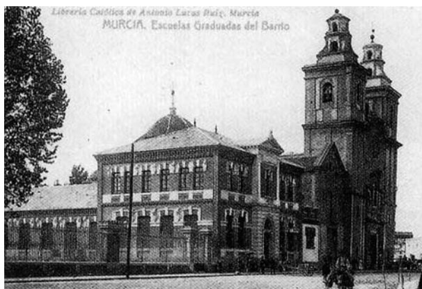
Figura 3. Sede original de la Universidad de Murcia, en las “Escuelas Graduadas”, edificadas en el popular Barrio del Carmen, junto a la Iglesia del mismo nombre. Aquí permaneció la Universidad desde 1920 hasta 1935, en que se trasladó al Campus de la Merced. Estas dependencias se destinaron a la enseñanza de Ciencias. Humanidades y Derecho se impartían en el Instituto Murciano de Segunda Enseñanza (actual “Licenciado Cascales”).
