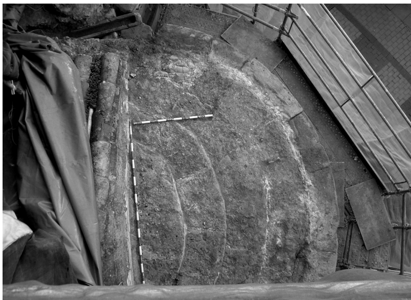
Lám. 1.1: Brazo sur del crucero tras la retirada de las diversas capas de mortero que lo cubrían; 2: Faldón de piedra en el ábside sur del lado del Evangelio.
