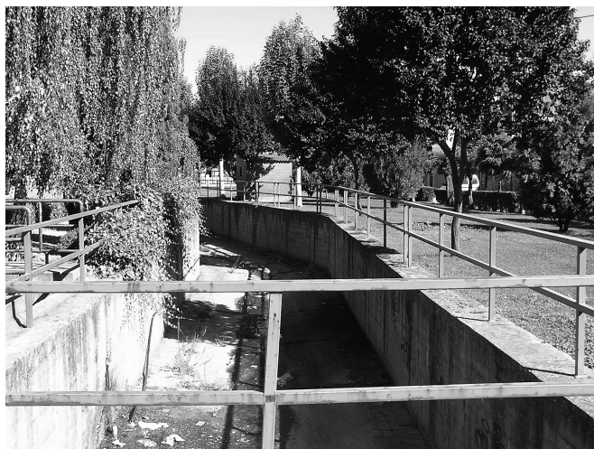
Canal del Rececillo, que sustituyó al antiguo reguero que se desbordó con la tormenta del verano de 1959, provocando la inundación.
