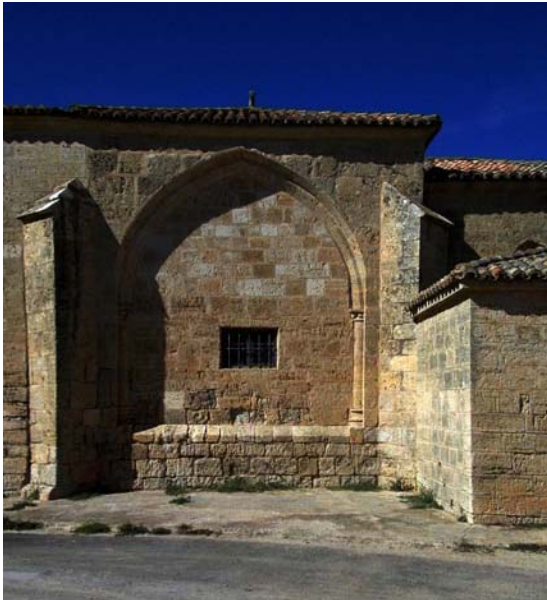
Capilla de Sasamón (Bu) que alberga el crucero escultórico. El templete gótico fue cerrado y la capilla ampliada hacia la cabecera y hacia los pies.
