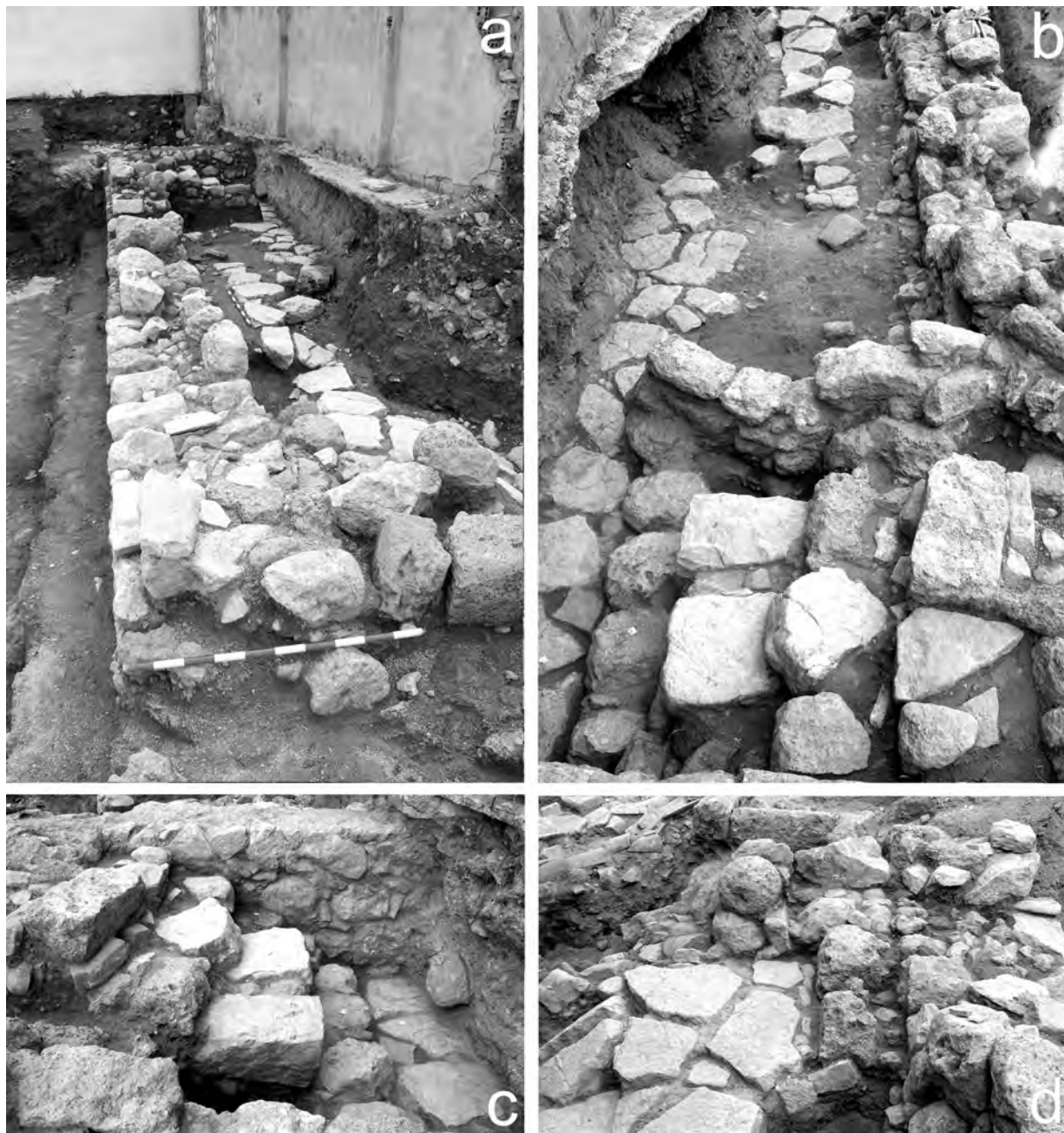
Lám. 9: C/Santa Ana, 8 (2010). Vestíbulo de entrada. a) Vista general del muro de fachada del hammām, con las escaleras de acceso desde la calle al fondo; b) Escaleras de entrada y restos del pavimento con losetas de piedra caliza; c) Detalle de las escaleras de acceso vistas desde el interior del vestíbulo; d) Detalle del poyo o banco corrido que presentaba este espacio, adosado al muro de fachada del edificio (derecha). Se aprecia un bolaño reutilizado como mampuesto.
