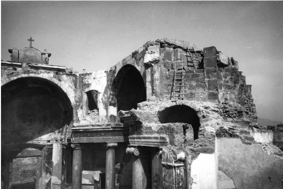
Fig. 2. Palermo. Chiesa di S. Lucia al Borgo, demolizioni, 1945 (per gentile concessione dell'Archivio fotografico "D. Cappellani").
