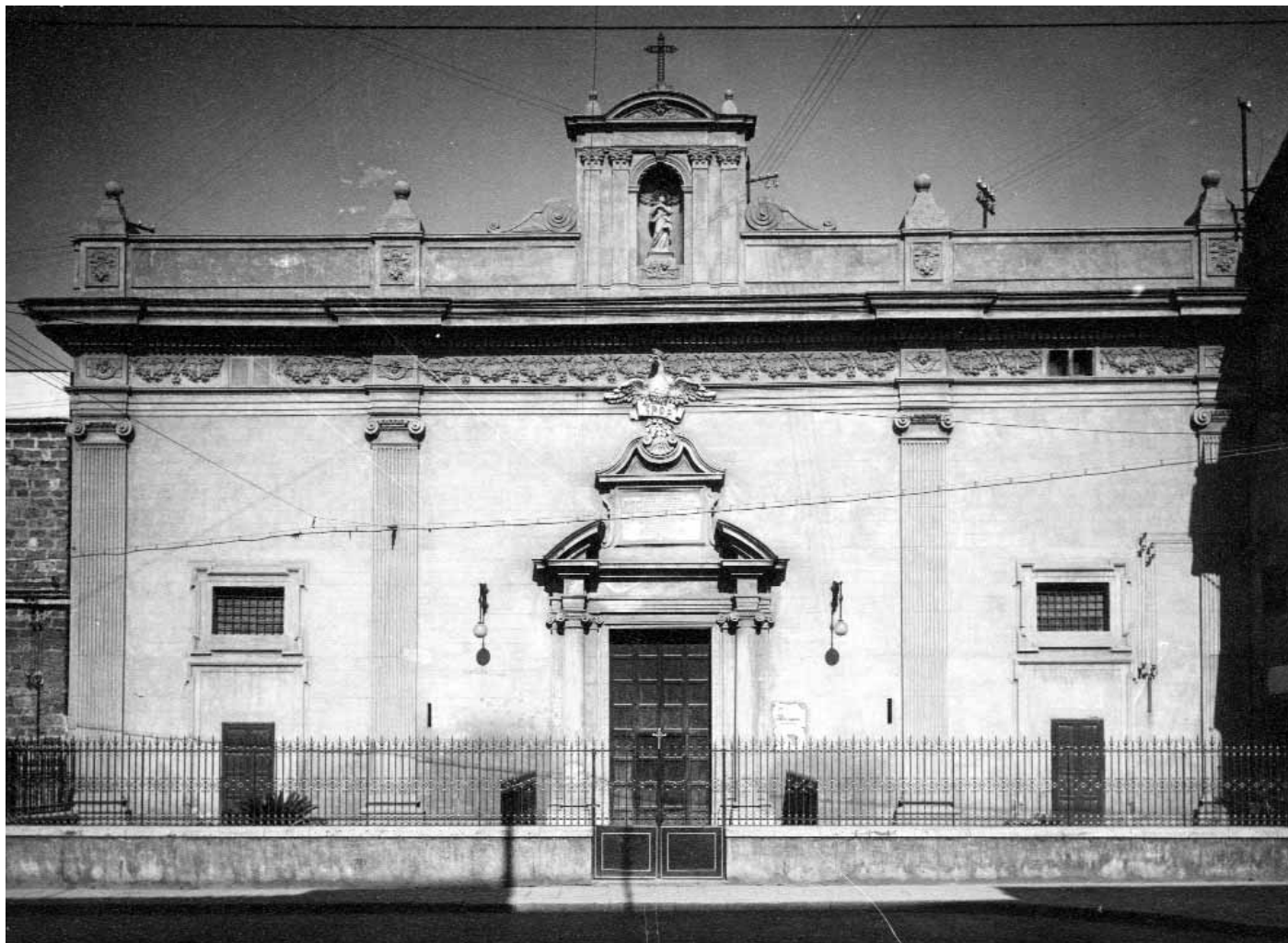
Fig. 6. Palermo. Chiesa di S. Lucia al Borgo, facciata, 1935 (per gentile concessione dell'Archivio fotografico "D. Cappellani").
