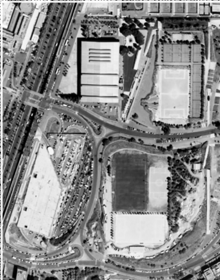
01 FOTOGRAFÍA AÉREA DEL EMPLAZAMIENTO DE LAS INSTALACIONES DE TIRO CON ARCO Y DEL PABELLÓN DE PELOTA
