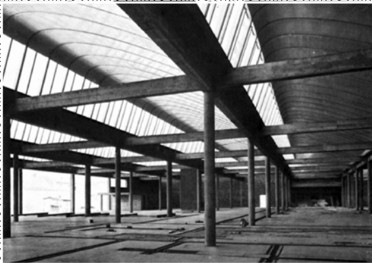
10 J. PROUVÉ Y B. ZEHRFUB; IMPRENTA EN TOURS (1950). FOTOGRAFÍA DEL INTERIOR
