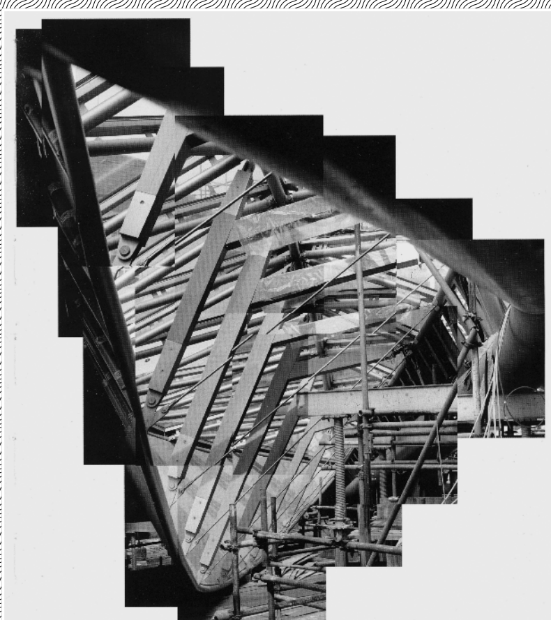
19 DETALL D'UN LLUERNARI DEL FOYER EN CONSTRUCCIÓ. FOTOMUNTATGE ORIGINAL EMBT
