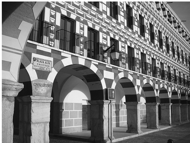
Vista de los trabajos de restauración efectuados.
