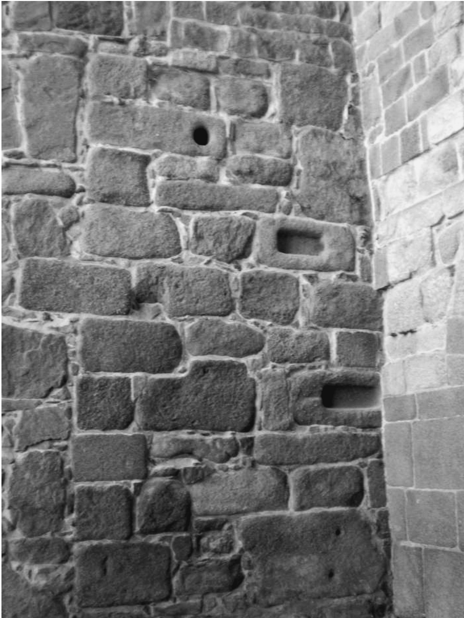
FIG. 1. Puerta de San Vicente; se pueden observar sillares y urnas cinerarias romanas reutilizadas (fotografía: María Estela González de la Granja).
