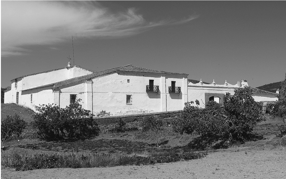
FIG. 11. Cortijo La Jayona. Fachada Sur.
