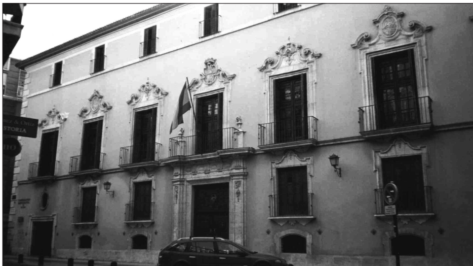
Figura 9 PALACIO FONTES, REHABILITADO ENTRE 1987-1991
