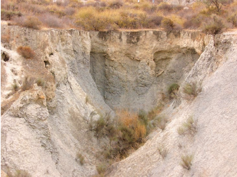
Figura 5. Socavón o colapso por piping en El Cautivo.
