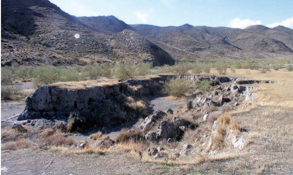
Figura 9. Terraza destruida por colapso de pipes y acarreamiento posterior en Rambla Honda.
