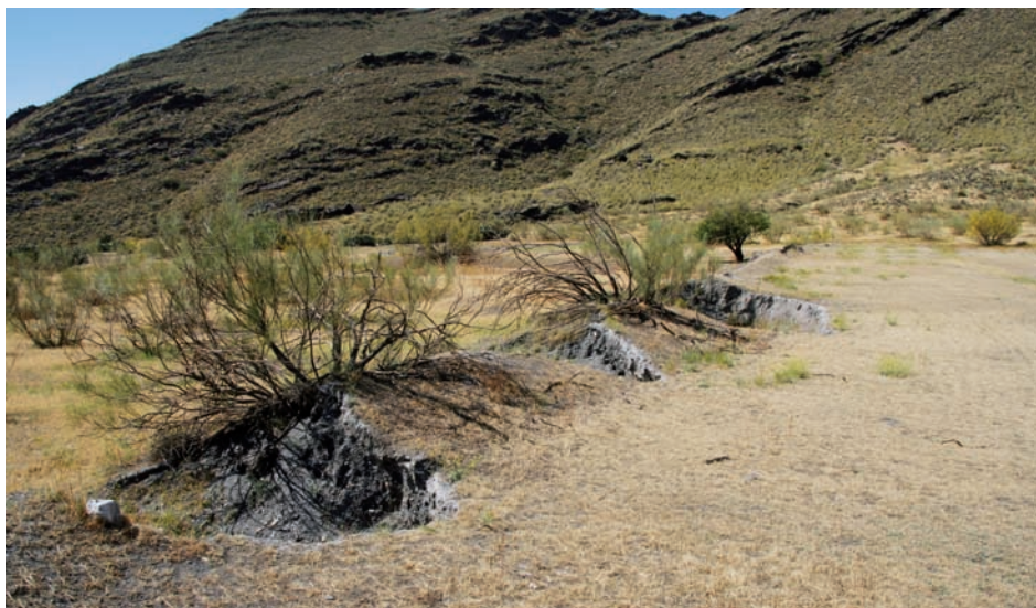
Figura 1. Bancales de Rambla Honda afectados por procesos de erosión originados por piping en sus muros.
