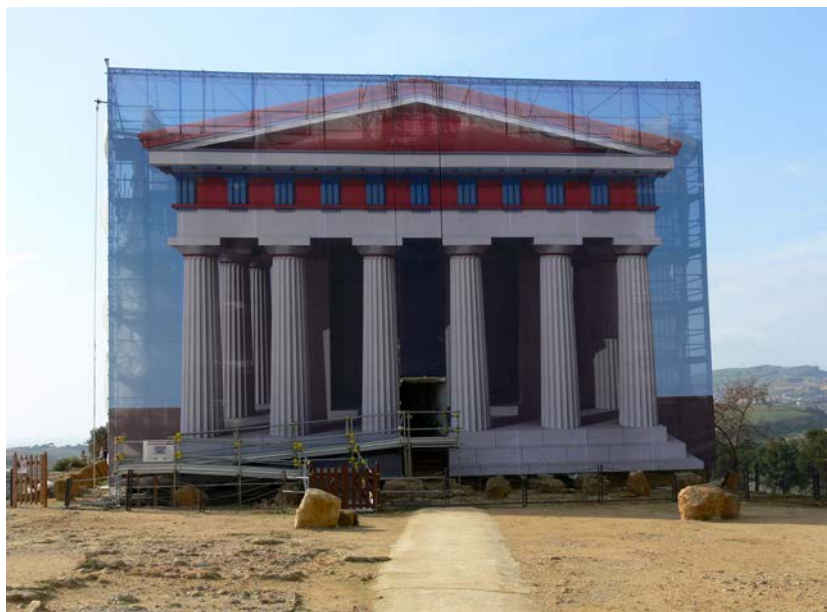
Imagen 5. Vista del templo de la Concordia en proceso de restauración, donde la malla que lo protege recrea la posible apariencia policromada que tuvo al momento de su consagración, aproximadamente en el 430 a.C. Valle de los Templos, Akragas, Sicilia, Italia. Fuente: fotografía del autor.
