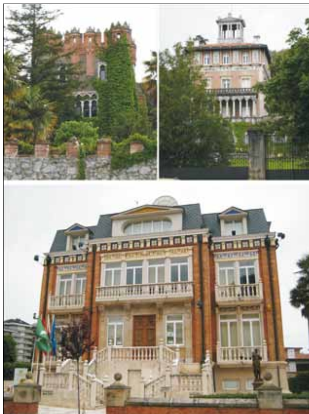
FIG. 19. Edificios de uso privado construidos por Eladio Laredo: castillo y palacete de Ocharan (arriba) y residencia-asilo de Dolores de los Heros (abajo). Fotografías: Carmen Delgado Viñas.
