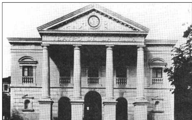
FIG. 13. Un edificio emblemático de la imagen urbana de la moderna ciudad industrial, el Teatro de la Villa. Fuente: Archivo Municipal de Castro Urdiales. «Castro Urdiales. Comienzos del siglo xx». La Ilustración de Castro .
