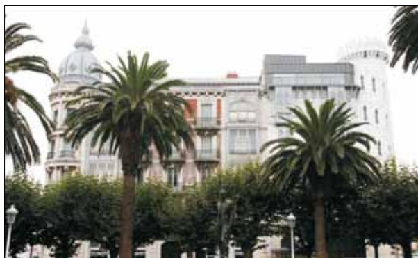
FIG. 20. Edificios de viviendas plurifamiliares en los jardines de la Barrera: casa de Emilia del Cerro (Severino Achúcarro, 1899) y edificio del Royal (Eladio Laredo, 1901). Carmen Delgado Viñas.
