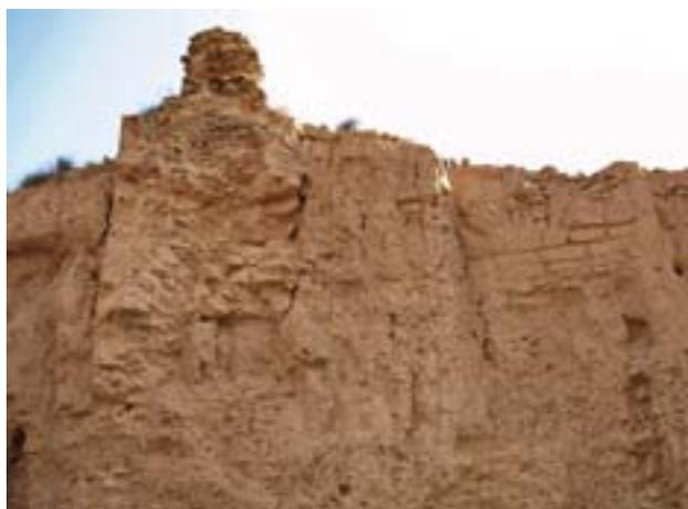
Sección tipo de la pantalla de la presa, espaldón y contrafuerte. Foto L. Argáiz.
