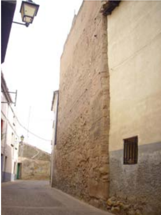
El "murrión", única torre del sistema defensivo probablemente islámico, que aún queda en pie en la calle Portillo de la Rosa. Foto A. Pérez.
