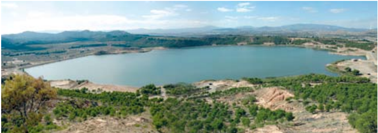
De gran relevancia para el desarrollo agrícola fue la construcción del embalse del Pantano-Perdiguero en 1885. Foto E. Sáinz, Comunidad General de Regadíos.
