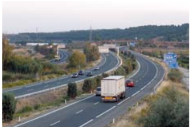
En la segunda mitad de los años 70, se construye la autopista Vasco-Aragonesa y la variante Sur de Calahorra. Foto J.L. Cinca.
