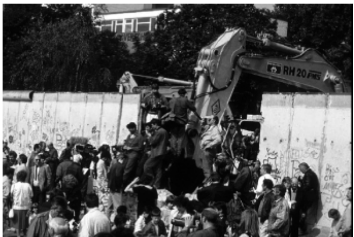
Demolición del muro, Junio 1990.
