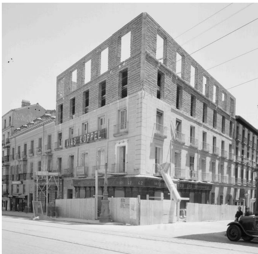
Fig. 1. Inmueble, con la tienda de antigüedades de Luis Ruiz en la parte baja, durante unas obras de ampliación. Esquina Carrera de San Jerónimo con calle Santa Catalina, Madrid. IPCE, Fototeca, Archivo Moreno.
