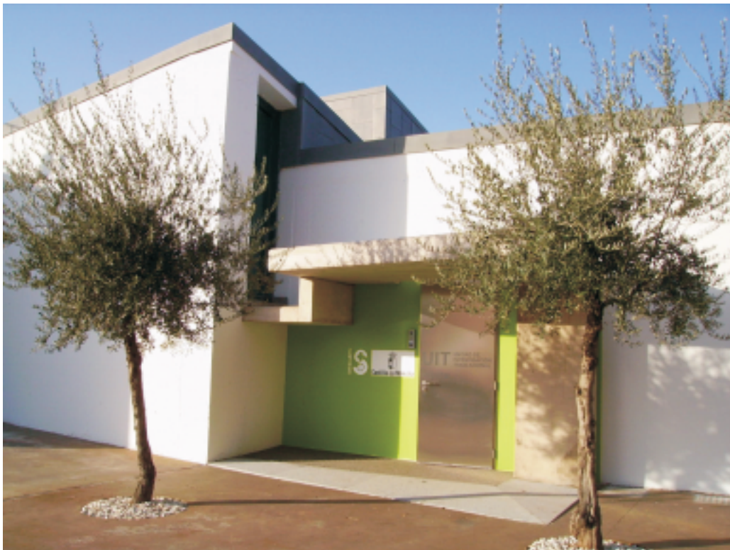
Figura 2. Edificio de la Unidad de Investigación Traslacional del HGUCR
