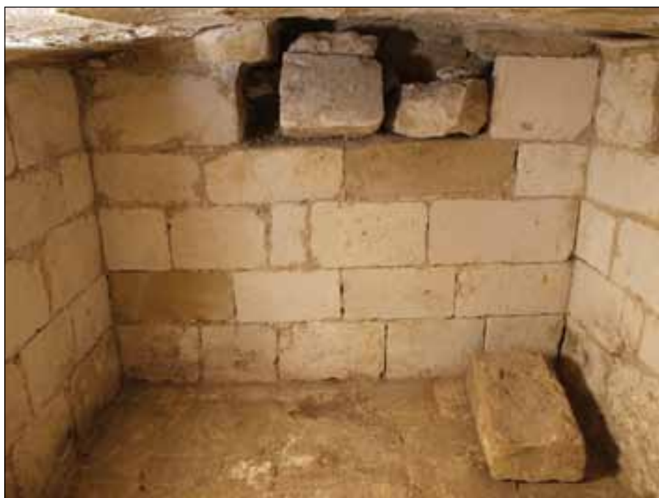
Lámina 10. Cripta al final de la excavación.
