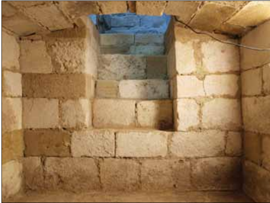
Lámina 11. Detalle de la escalera de acceso al interior de la cripta.
