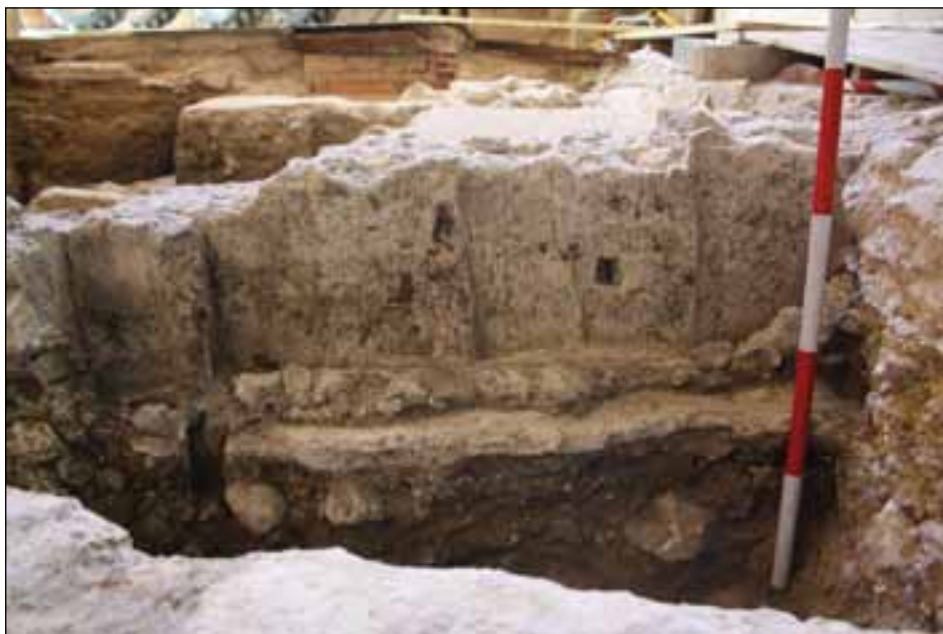
Lámina 20. Detalle de la impronta del encofrado en el muro occidental de la iglesia antigua.
