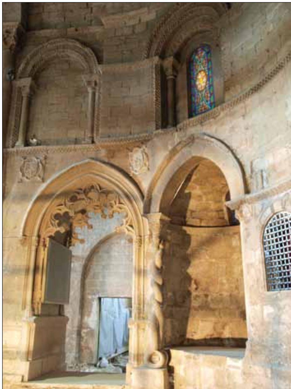
Lámina 3. Zona en la que se localizaba el arcosolio con los primeros enterramientos de los mariscales de Navarra.
