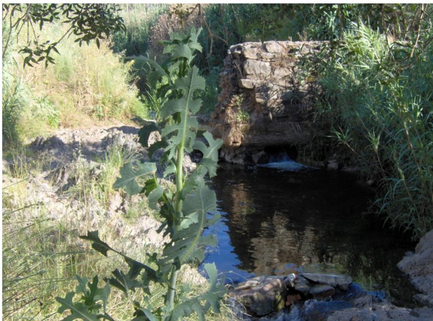
*Azud en el Harnina, que aún conserva una compuerta inferior donde se aprecia la salida de agua.*
