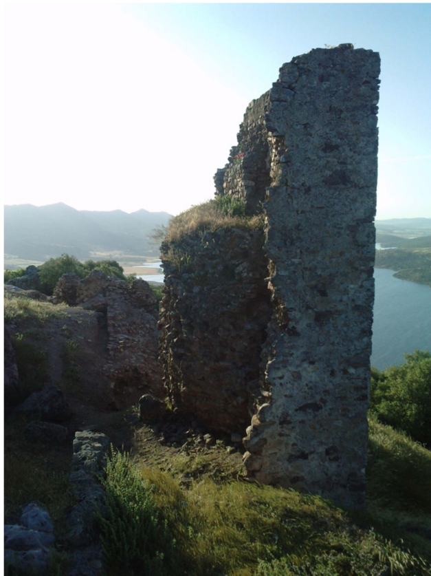
Fig. 4: Vista lateral occidental de la torre de la solana.
