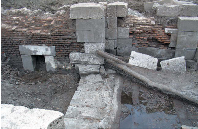
Figura 8. Detalle de los restos de una de las esclusas del canal del Manzanares. (Fotografía cortesía de Álvaro Bonet)
