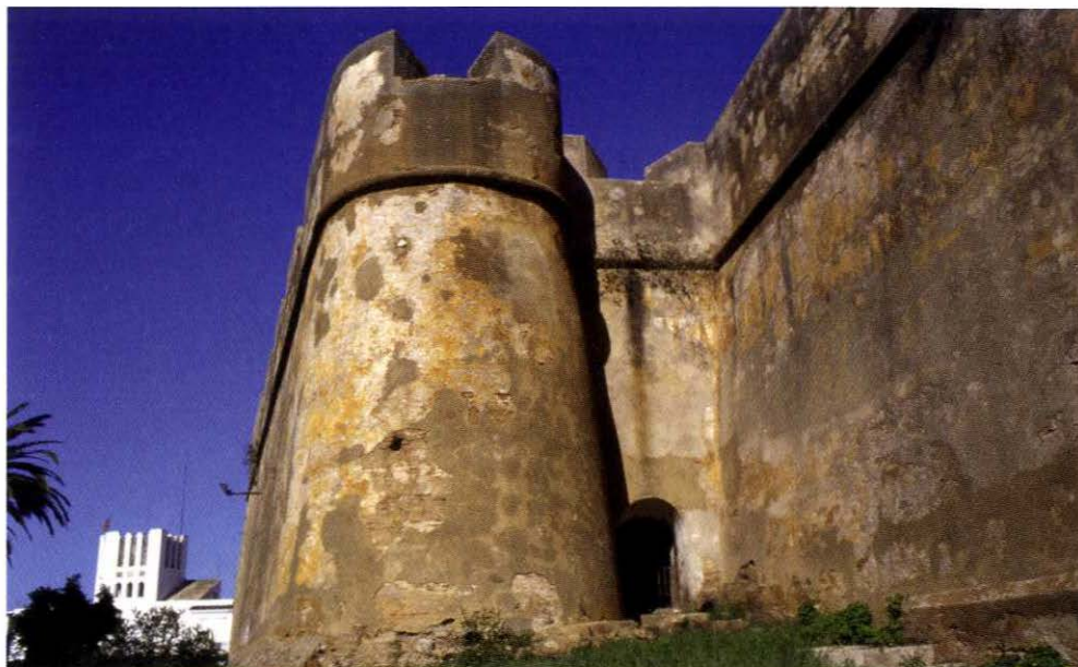
Fig. 7: Orejón del baluarte del suroeste, través (con su casamata) y parte de la cortina del frente de tierra del castillo de Santa María. Fotografía del autor.
