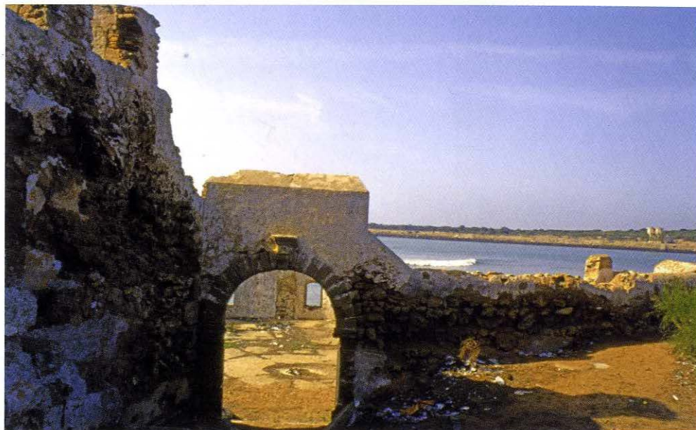
Fig. 32: Reducto circular junto a la playa. Ménsula de corte clasicista en la clave del arco de la puerta de entrada al mismo. Fotografía del autor.
