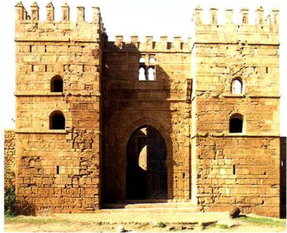
Fig. 18. Porte d'entrée dite Bab jdid.
