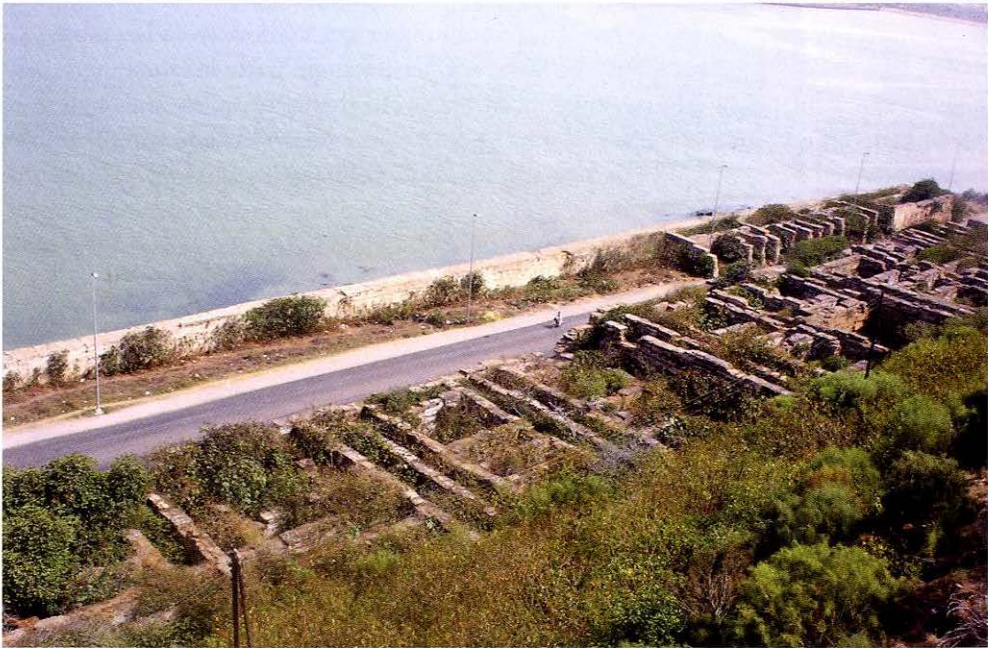
Fig. 17. Les constructions cellulaires: vue d'ensemble.
