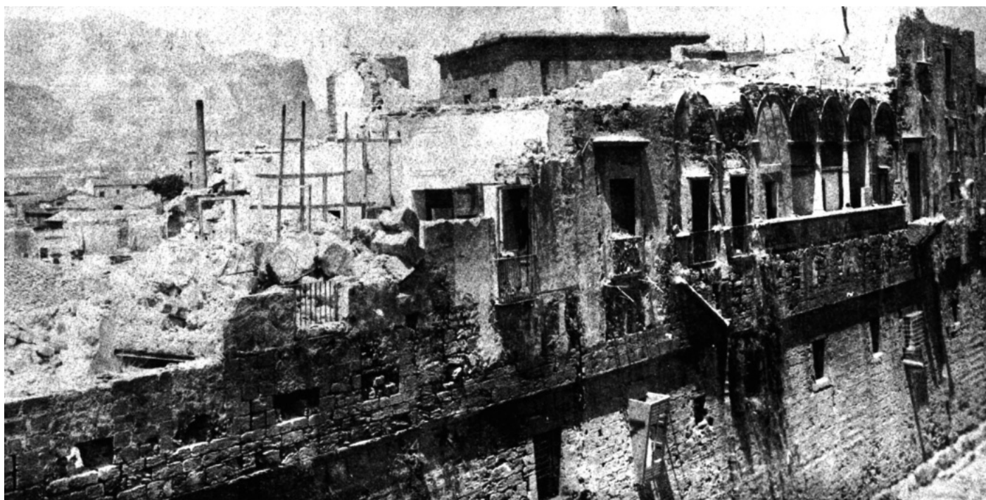
Fig. 13. Il "palazzetto" rinascimentale durante le demolizioni del 1922 (da R. La Duca, Il Castello a ... , cit.).
