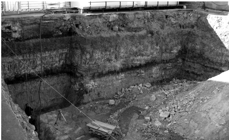
Fig. 4: Fotografías de la intervención: sondeo IV y perfil del solar tras su vaciado.
