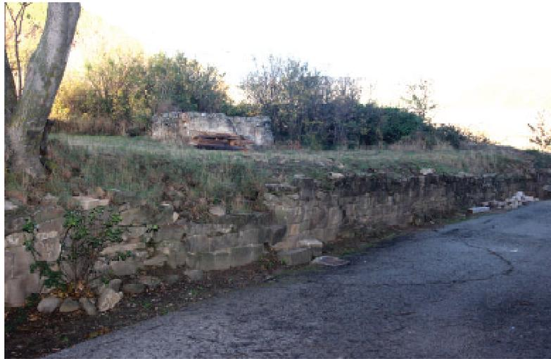
*Fig 3.- Murete de contención con piezas reutilizadas*
